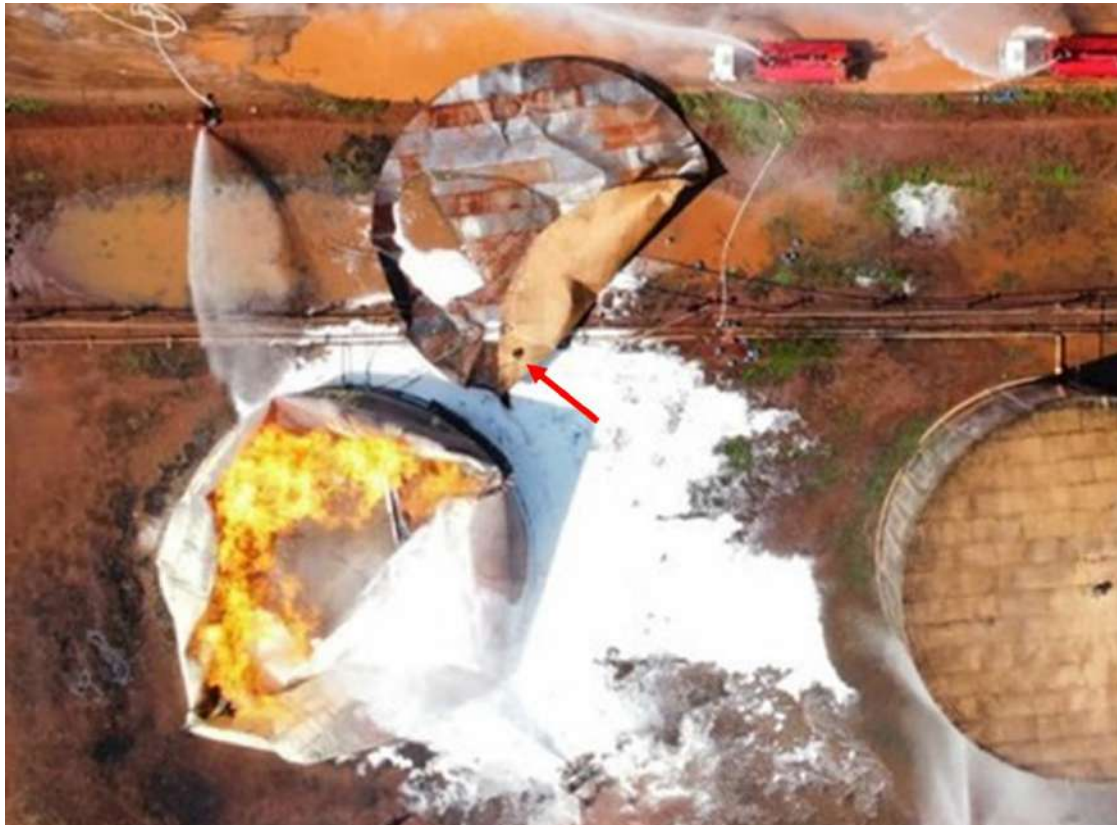
Figura 25 – Vista aérea do TQ-03 em chamas. No detalhe, a indicação da posição da boca de visita.
