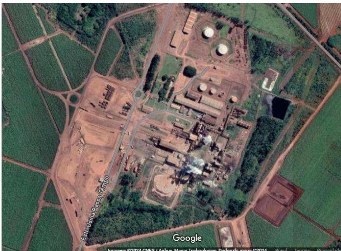
Figura 1 – Vista aérea da instalação.
