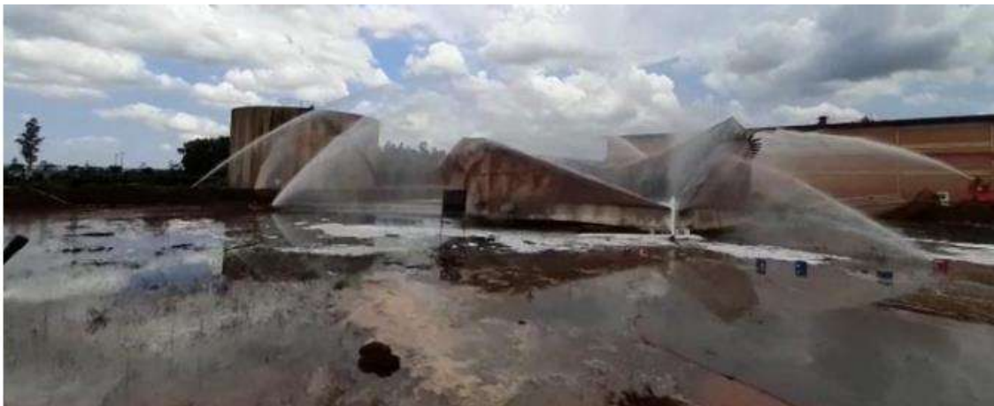
Figura 5 – Resfriamento do TQ-03 após extinção do fogo.
